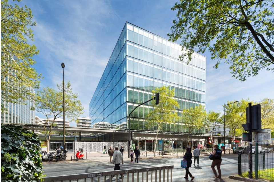
Fuente: Sergio Grazia, Edificio de Oficinas Avenida Leclerc
