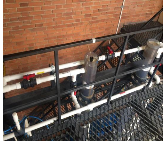
Filtro rápido descendente FRD 4.
