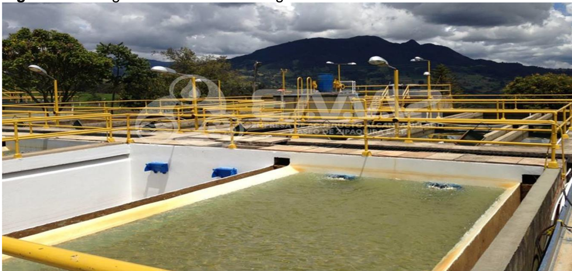
Figura 3. Vista general de la Planta Regional
