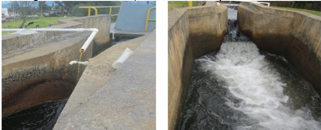
Figura 8. Suministro PAC planta convencional y canaleta Parshall
