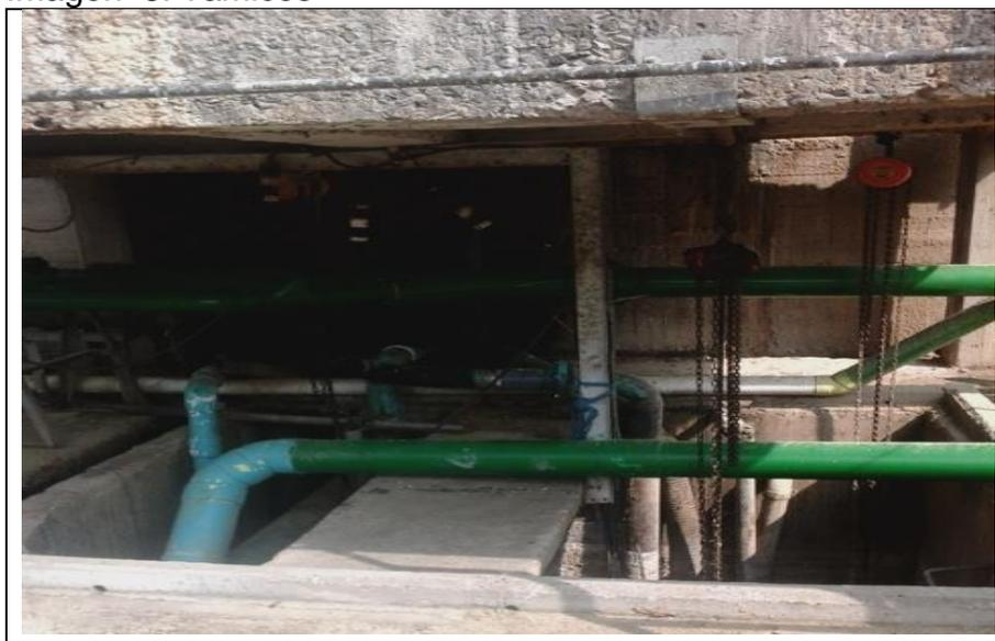
**SEDIMENTADOR PRIMARIO:** este equipo recibe el efluente que proviene de los tamices, en esta unida se realiza una oxidación primaria de dicho caudal donde se retienen los sólidos suspendidos por sedimentación. En la PTAR se tiene dos sedimentadores primarios en paralelo los cuales tienen las siguientes medidas, caudal y tiempo de retención.
