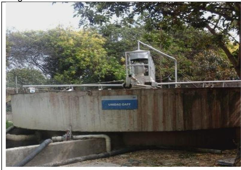
**ALIMENTACION AL D-CANTER:** Las grasas y lodos luego de ser removidos en la unidad DAF son llevados a un tanque colector, de donde posteriormente se envían a una centrifuga súper D- Canter, en la cual se deshidratan y se envía para el compostaje.
