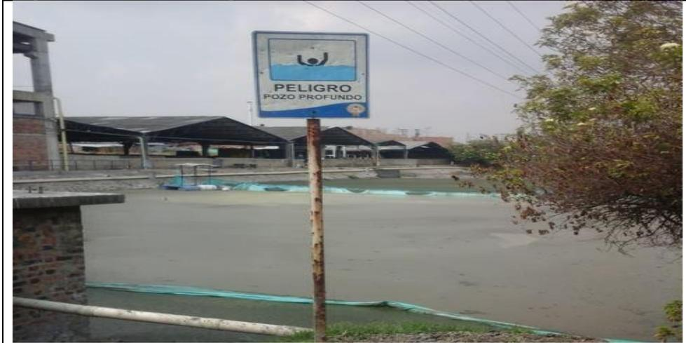
TERCERA LAGUNA DE ESTABILIZACIÓN: El efluente de la primera laguna pasa a esta tercera con un tiempo de retención de 3 días, en donde se continúa el proceso de estabilización y posteriormente es vertida al cuerpo receptor.
