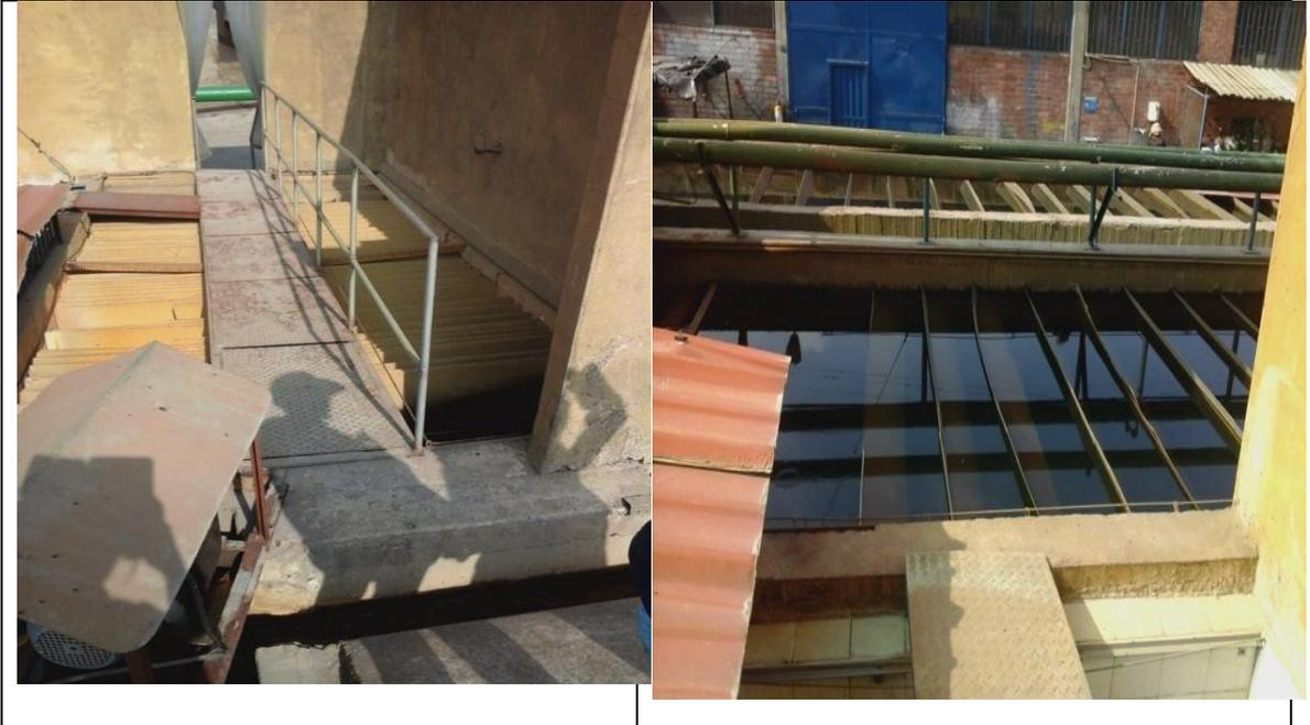
**HOMOGENIZACIÓN:** En este proceso se recibe el agua clarificada mediante un tanque pulmón, permitiendo cierto grado de oxigenación y regulando el caudal para que la bomba de los filtros se accione automáticamente y así iniciar la succión hacia los lechos filtrantes.
