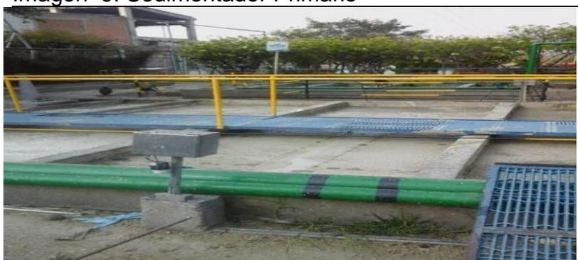
**TOLVA DE CONTENIDO RUMINAL:** en este para se realizar la remoción de un porcentaje de sólidos suspendidos, por sobrenadantes y por decantación. La tolva de contenido ruminal, permite la deshidratación de los sólidos, con el fin de enviar el líquido separado al sedimentador primario y los sólidos a la zona de compostaje
