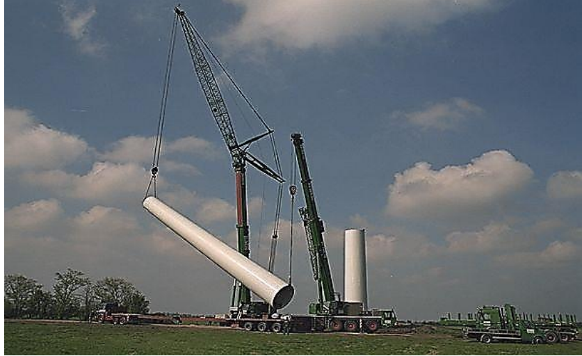
Imagen 20. Torre tubular de acero
