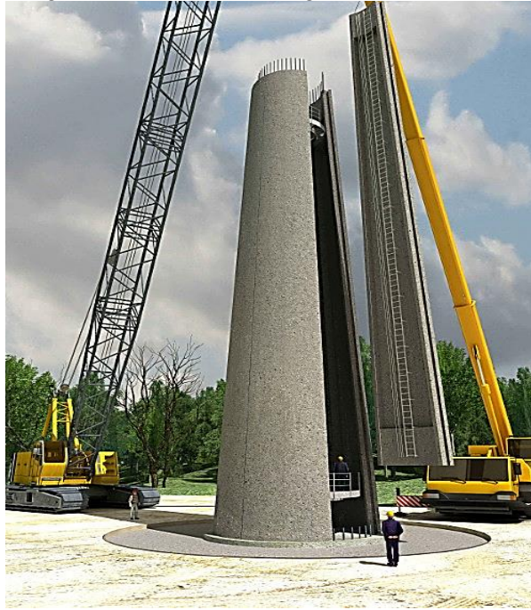
Imagen 19. Torre de hormigón
