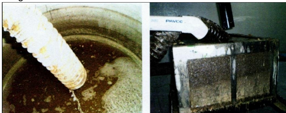
Imagen 3. Entrada PTAR No 3
