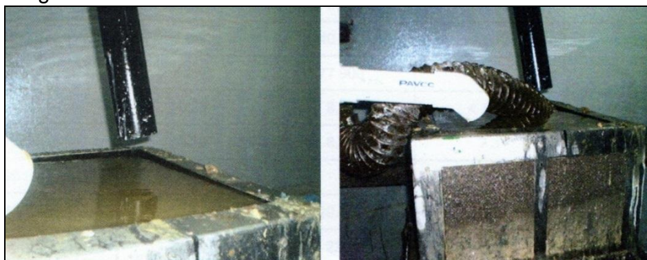
Imagen 1. Entrada PTAR No 1
