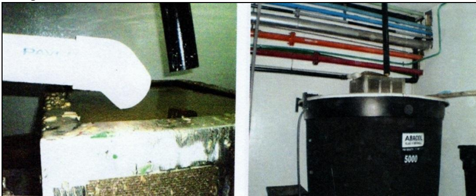
Imagen 2. Entrada PTAR No 2
