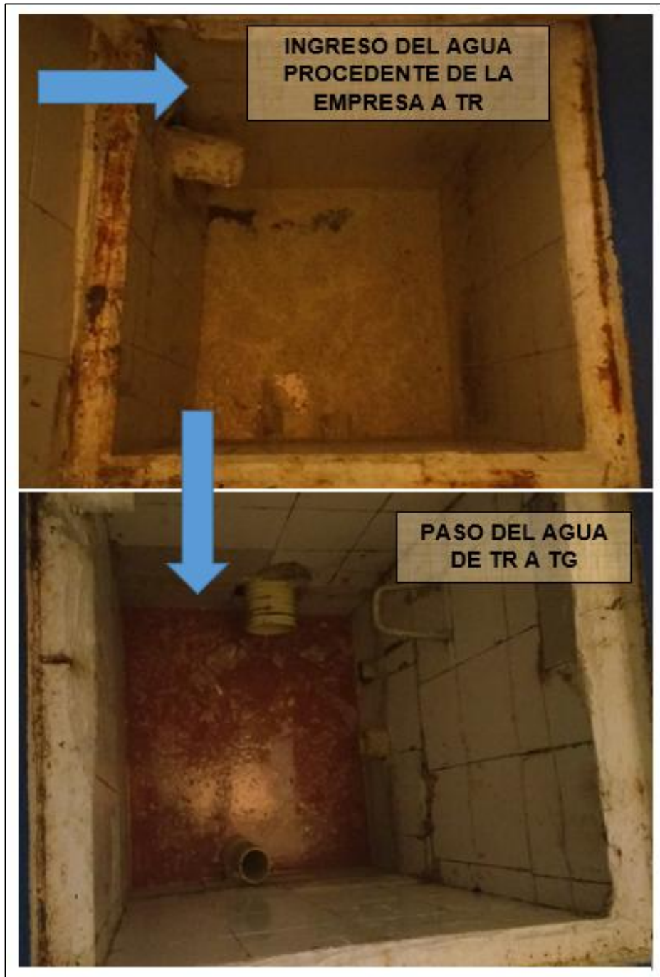
Figura 6. Disposición de la trampa de grasas y flujo de agua a través de ella.
