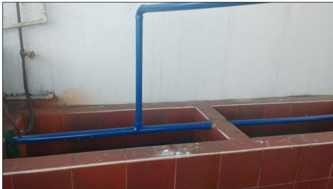
Figura 10. Filtro de arena.
