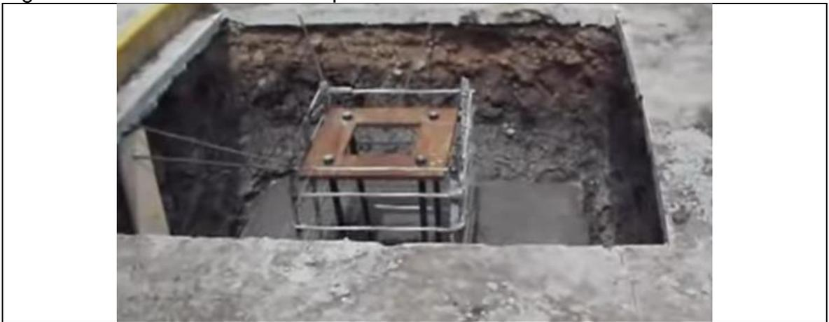
Se colocará el riel sobre los soportes de amarre y con ayuda de las platinas de sujeción y las tuercas se procede a ajustarlos, como se muestra en la Figura 144.
