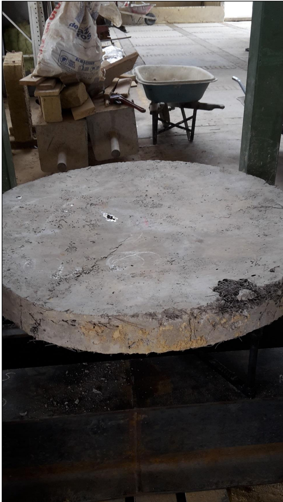
Foto 45. Fractura en la parte superior
