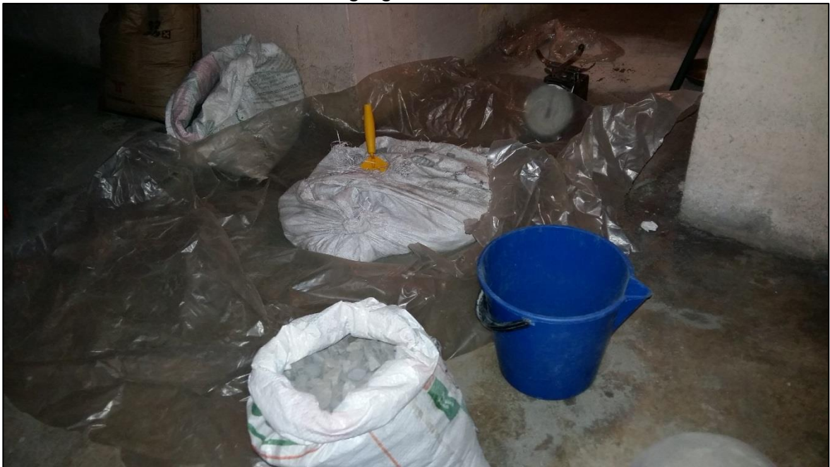
Foto 15. Proceso dosificación de agregados
