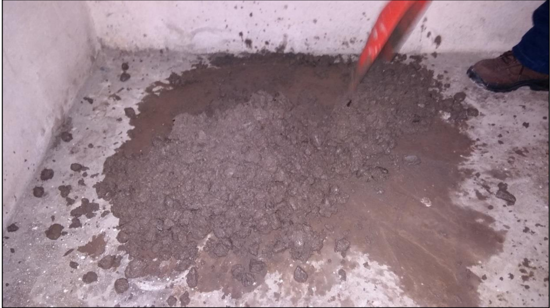
Foto 17. Proceso de mezcla sin presencia de fibra
