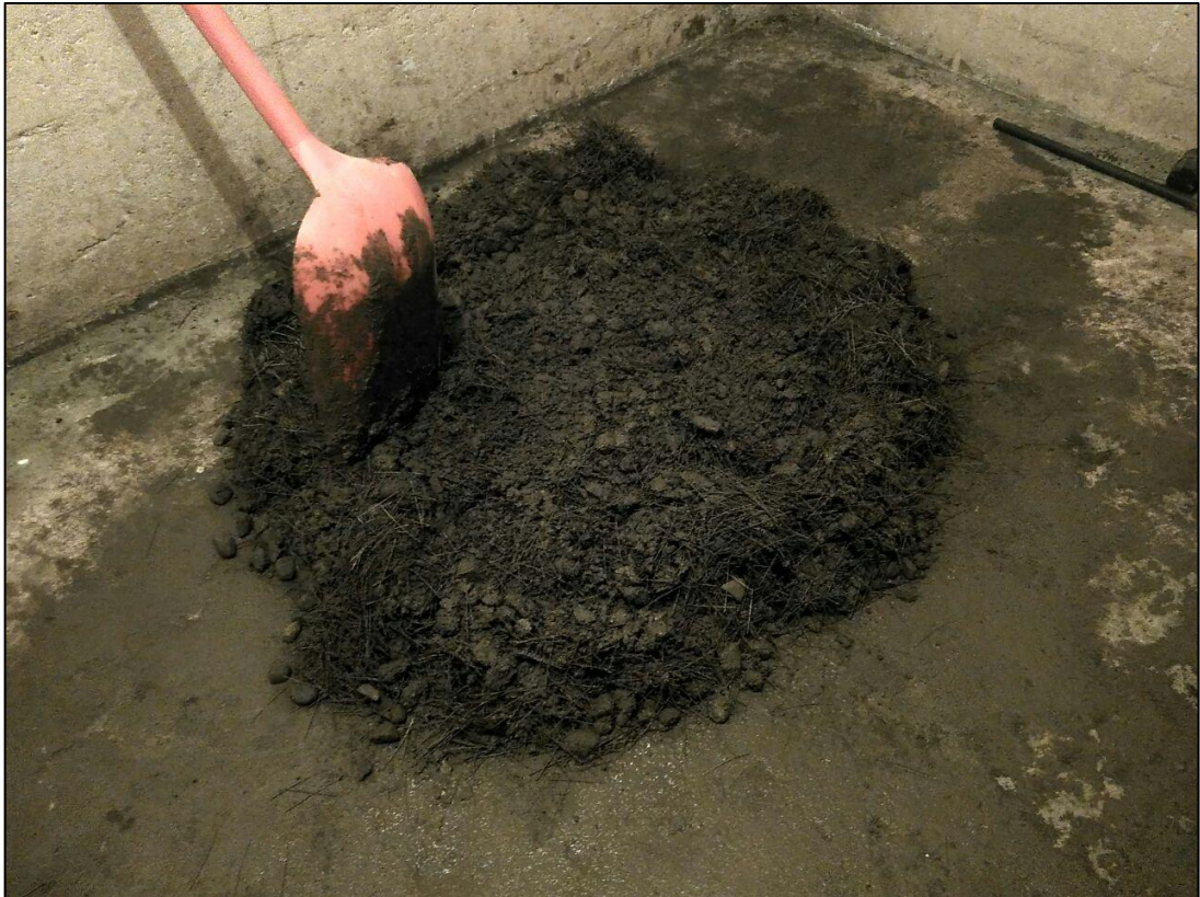
Foto 18. Proceso de mezcla con presencia de fibra polimérica
