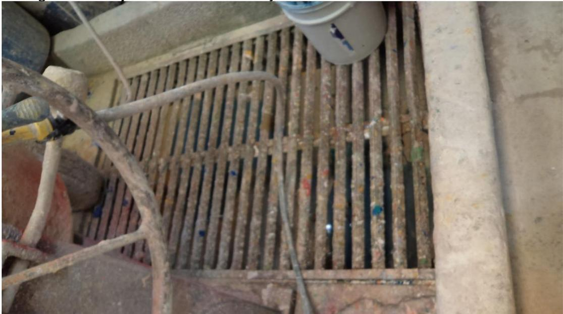
**2.3.4 Trampa de grasas.** La trampa de grasas se utiliza con el fin de retirar los residuos de grasas y aceites que lleva el efluente, además, ésta remueve partículas con diámetros grandes y residuos de pinturas. El tiempo de retención en la trampa de grasas es de tres minutos y la misma se observa en la fotografía 4.
