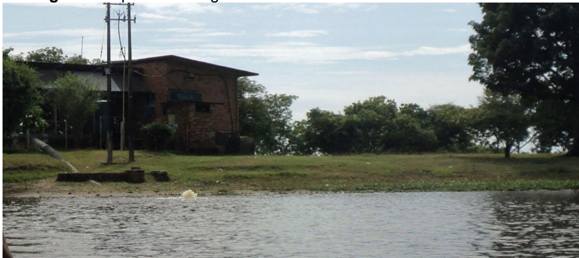
Imagen 2. Captación de agua en tubería de Fertilizantes Colombianos S.A.
