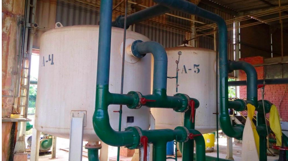
Imagen 9. Filtros Bicapa A-4 y A-5
