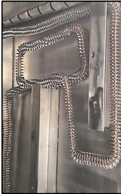
Figura 11. Serpentín del sistema de condensación del agua.
