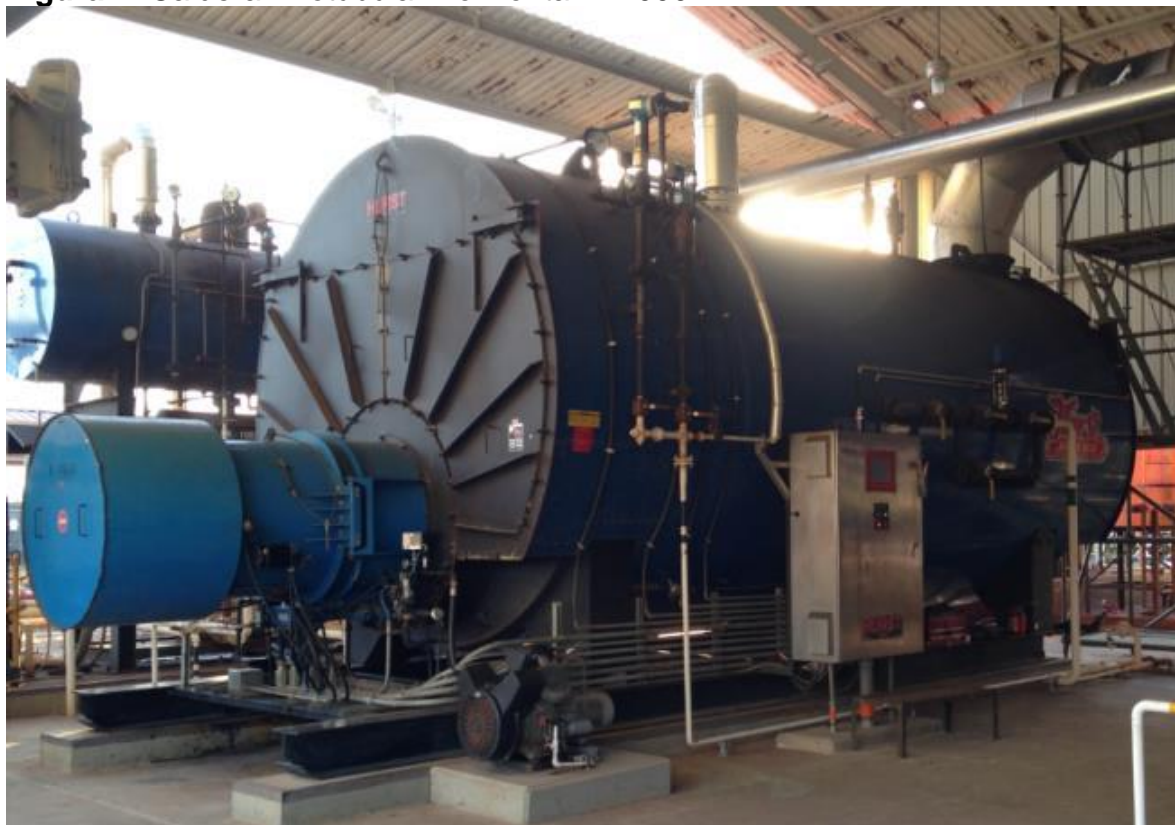
Figura 4. Caldera Pirotubular Horizontal B-2000.
