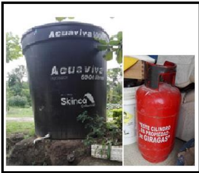
Figura 4. Tanque de 6000 L y cilindro de gas propano (GLP)
