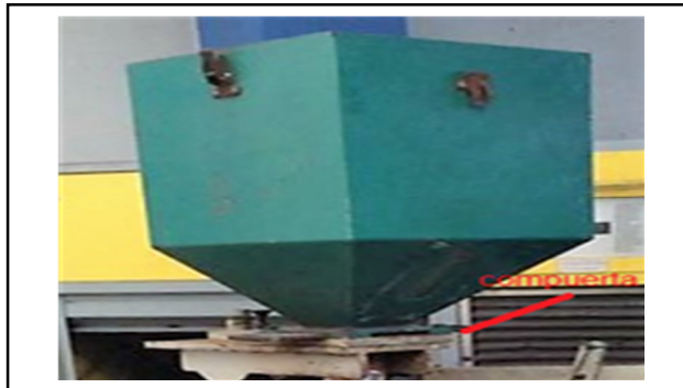
Imagen 103. Compuerta de salida de la tolva
