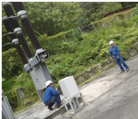
Imagen 4. Colaboradores realizando labores de medición Subestación Tequendama.
