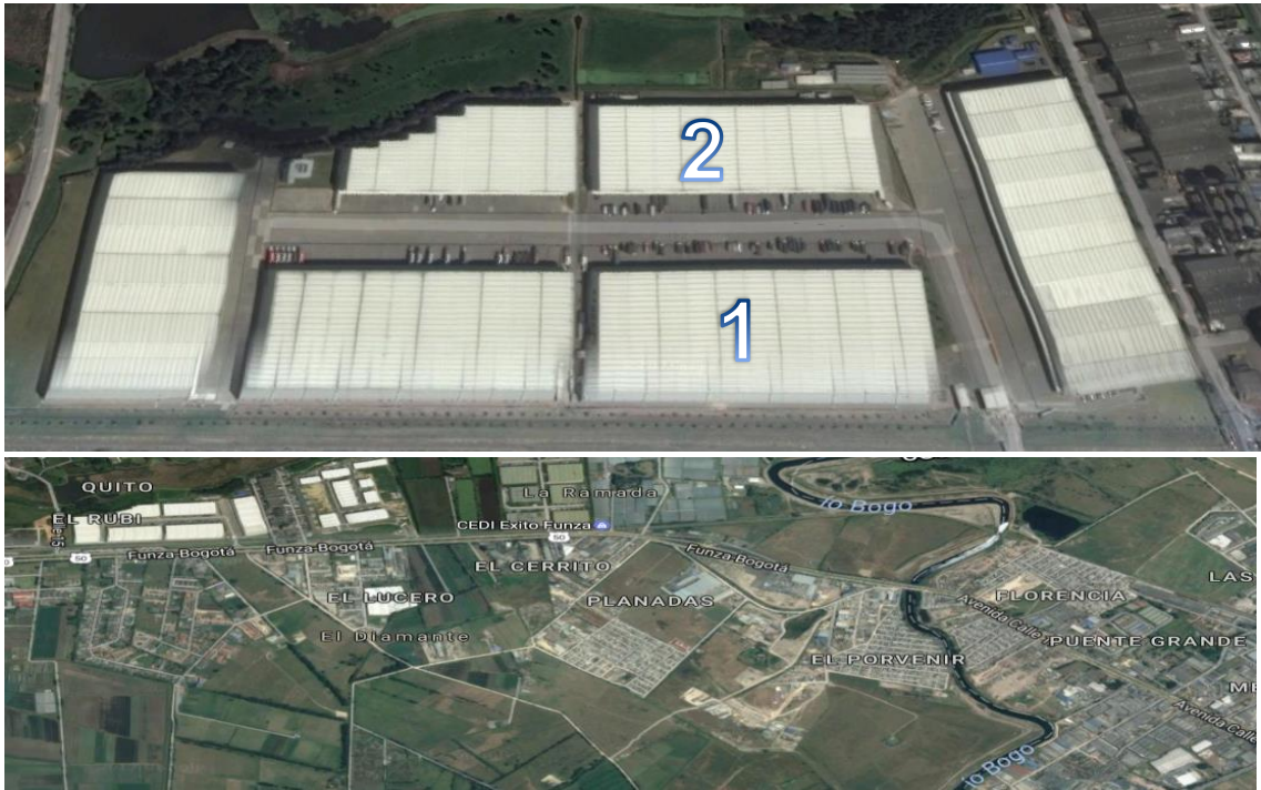
Figura 49. Instalaciones del CEDI de distribuciones Corbeta
