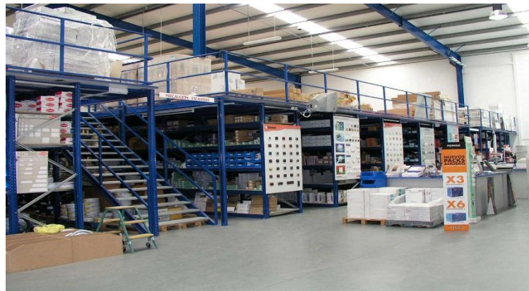
Figura 32. Ejemplo de entrepisos y mezzanines
