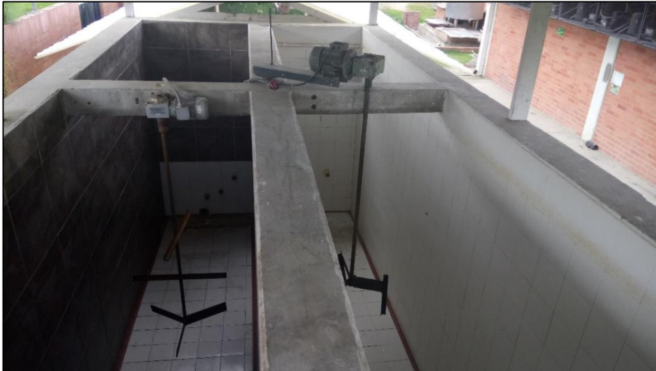
Figura 9. Tanques de clarificación de agua antes del inicio del proceso donde se remueven lodos y trazas de residuos disueltos.
