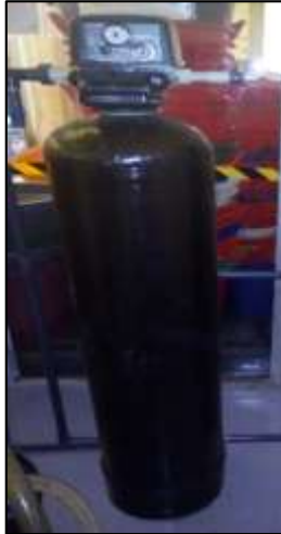
Imagen 4. Filtro de arena
