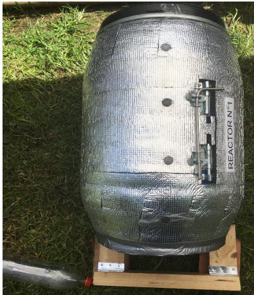
Imagen 4. Reactor instalado recubierto con el material aislante (Espuma de Poliuretano).
