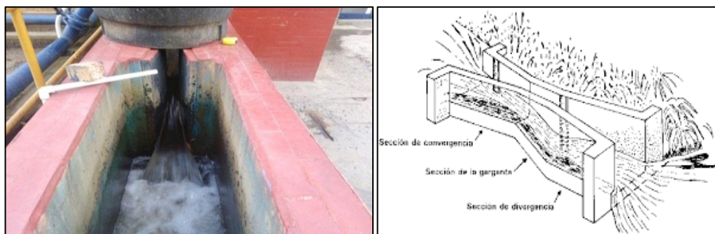
Figura 4. Unidad de mezcla rápida
