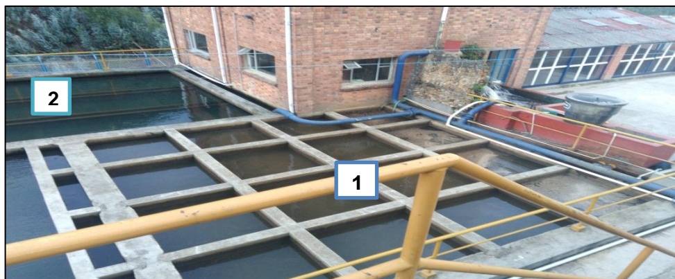
Figura 3. Vista panorámica de la planta de tratamiento Galán
