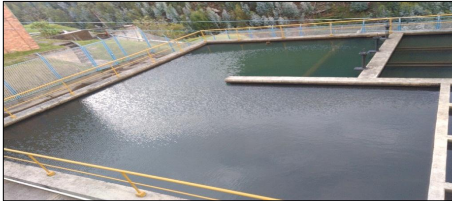
Figura 6. Sedimentador convencional y tipo colmena
