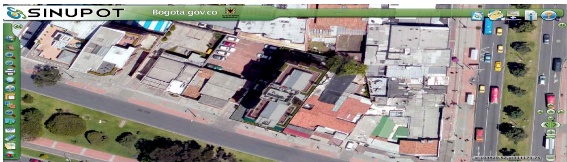
Figura 35. Panorámica del local
