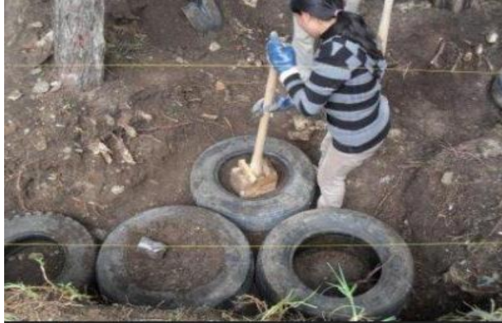
Ilustración 3 Relleno de llantas con material Seleccionado.
