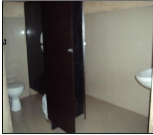
Baño sala de Proyectos
