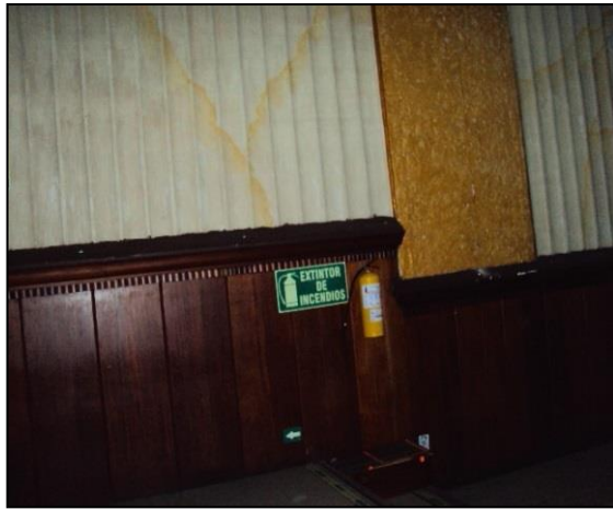
Detalle De Muro Sala
