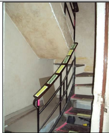
Escalera sala de Proyectos
