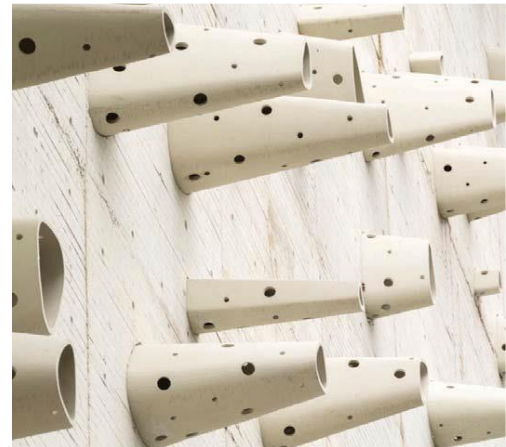
Imagen 10. Elemento prefabricado GRC, fachada oriental
