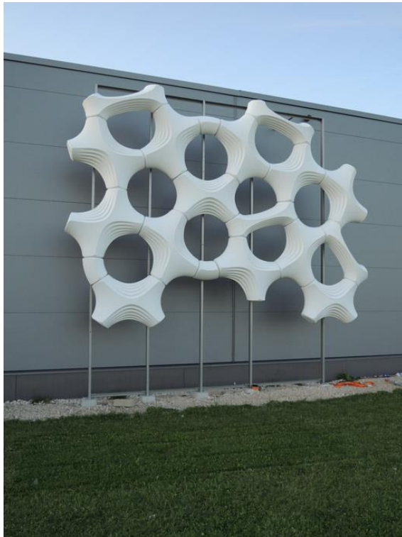
Imagen 19. Anclaje Fachada prosolve 370e
