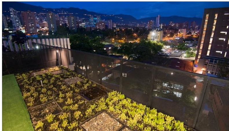
Imagen 13. Cubiertas Centro Argos
