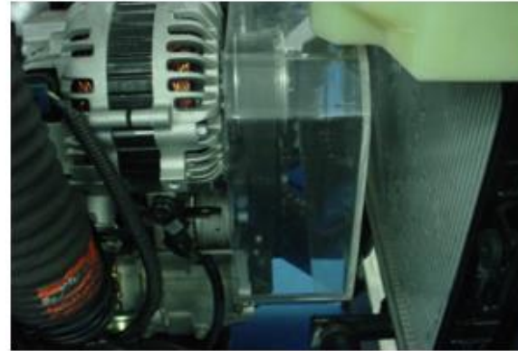
VISTA DE PROTECCIONES DE SEGURIDAD
