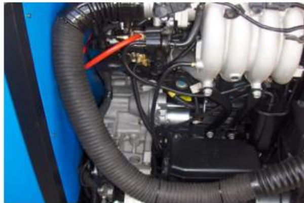
VISTA DE MANGUERA DE GASOLINA HACIA EL MANÓMETRO (MANGUERA ESPECIAL DE SEGURIDAD)
