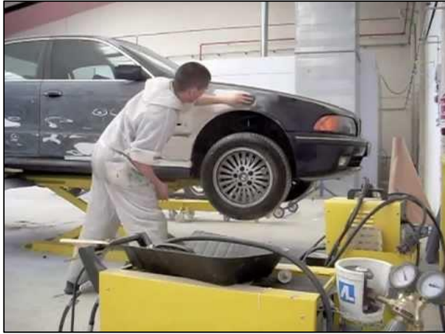
Figura 11. Preparación de superficie por lijado
