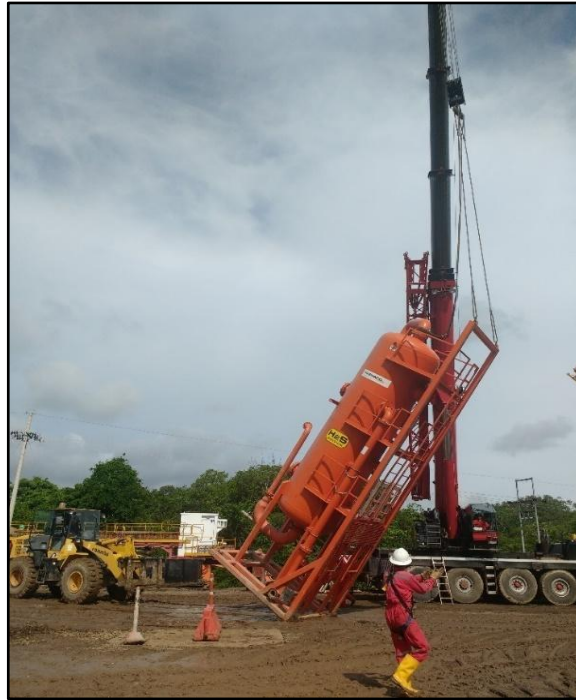
Figura 15. Desmante del Poor Boy.
