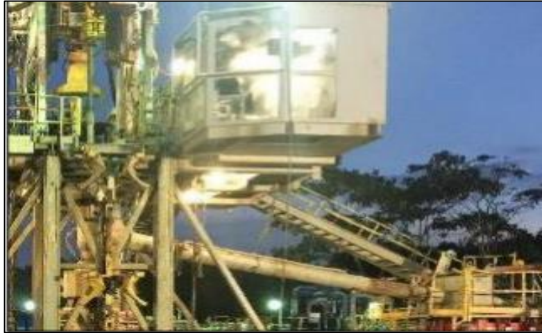
Figura 11. Cabina del perforador del Rig 50.
