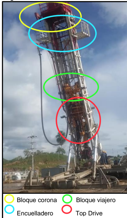
Figura 24. Rig Down de la torre del Rig 50.
