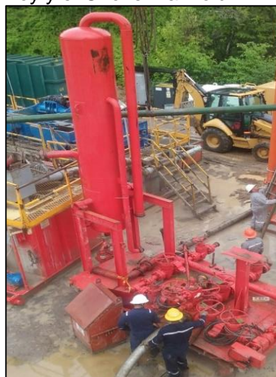
Figura 23. Rig Down del Poor Boy y el Choke manifold
