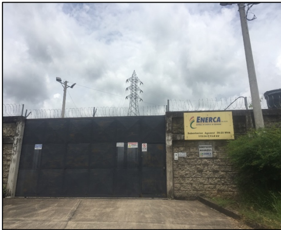
Km 1. Subestación Aguazul Enerca.
