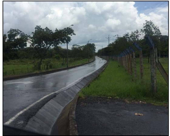
Km 19. Entrada carretera lateral derecha
