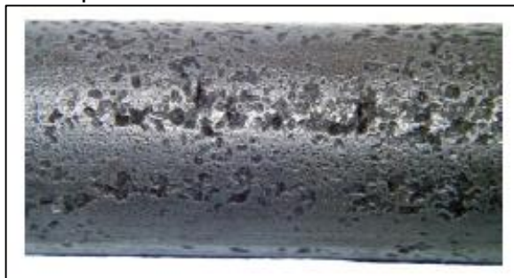
Figura 24. Daño en varillas por corrosión dada por cloruros.
