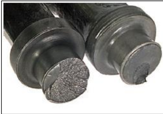
Figura 22. Daño en varillas por conexión.
