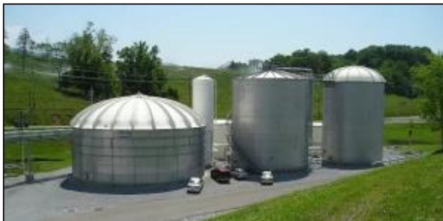
Imagen 3. Tratamiento anaerobio para la depuración de aguas
