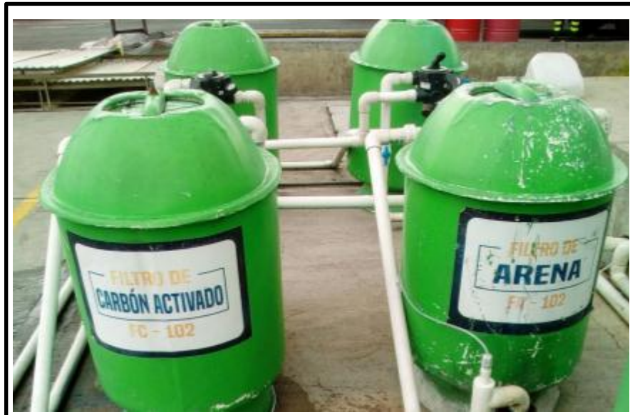
Figura 5. Módulo de filtros
