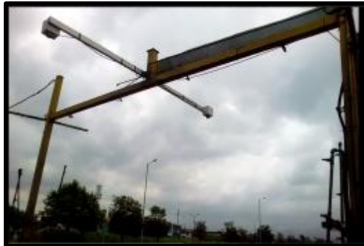
Figura 2. Arco 1 de lavado- sensores
