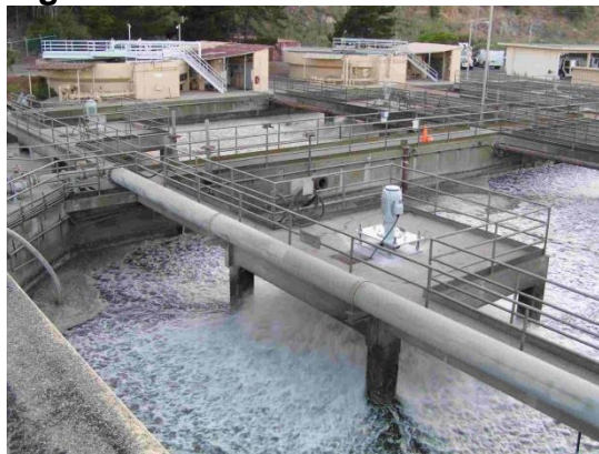
Figura 9. Planta de lodos activados
