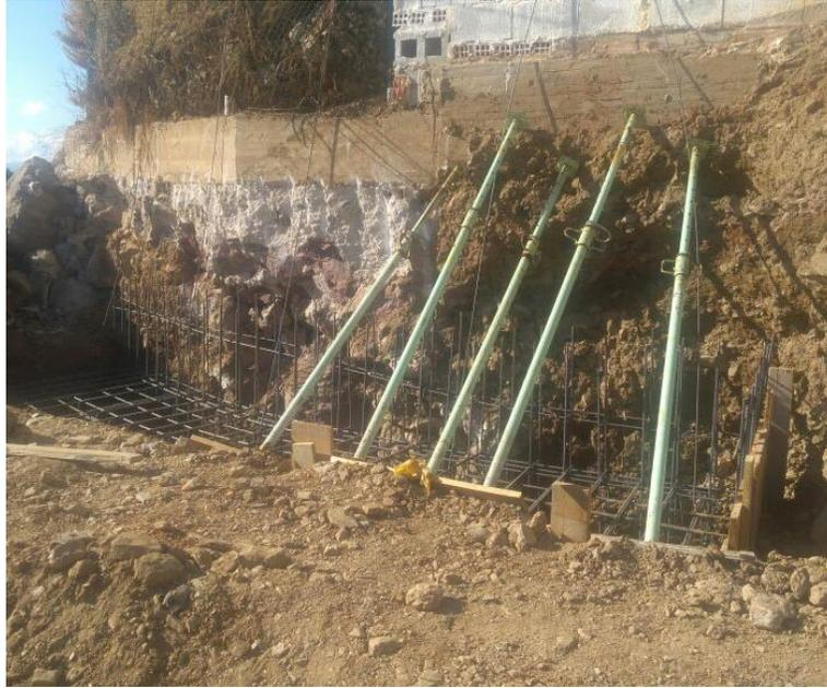
**Fotografía 17. Armado de vigas**
