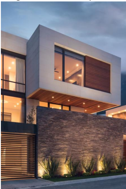
Imagen 80. Referente para fachada 2
