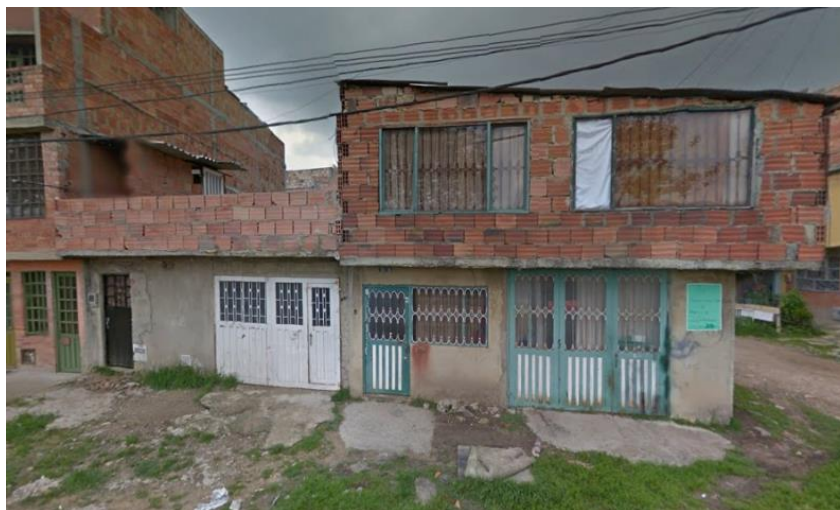
Ilustración 15. Estado Actual Zona de Intervención.
