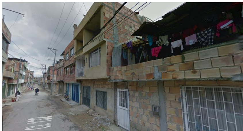
Ilustración 16. Estado Actual Zona de Intervención.
