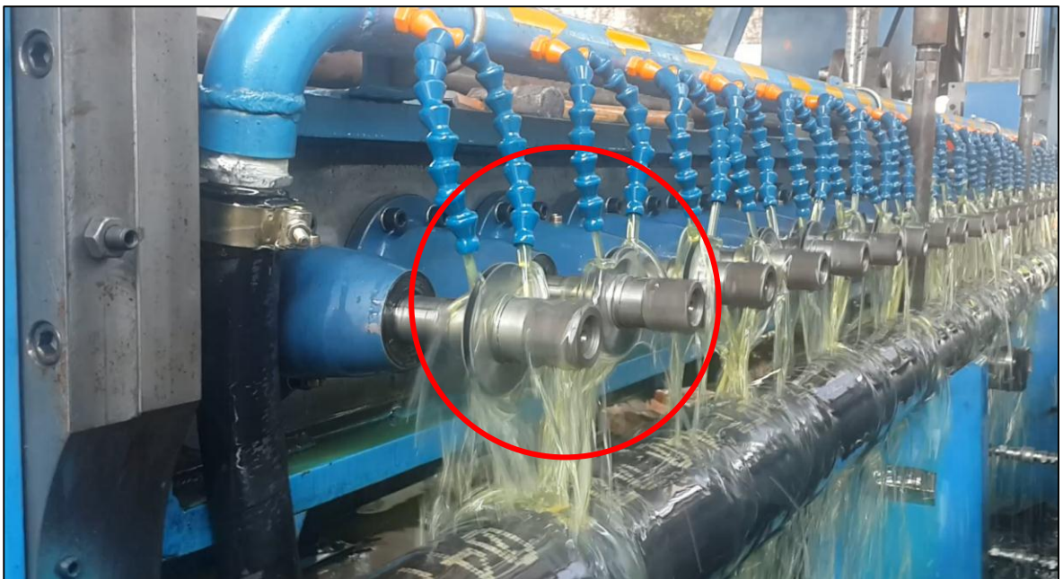
Imagen 20: Verificación de la máquina
