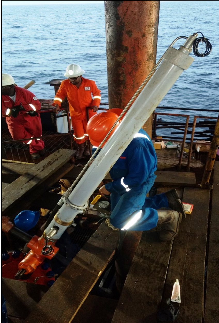
Figura 18. Instalación del pedestal.
