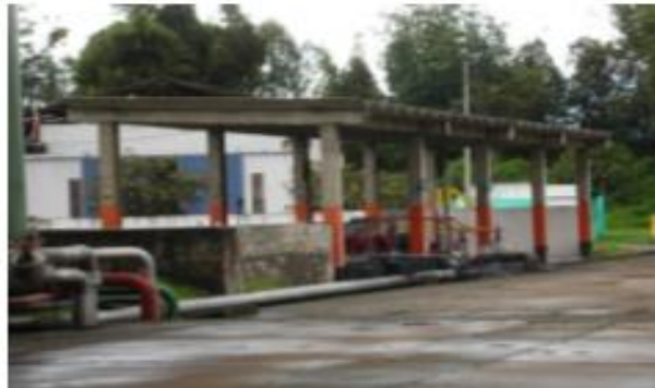
Figura 13. Estructura para el bombeo de ACPM
