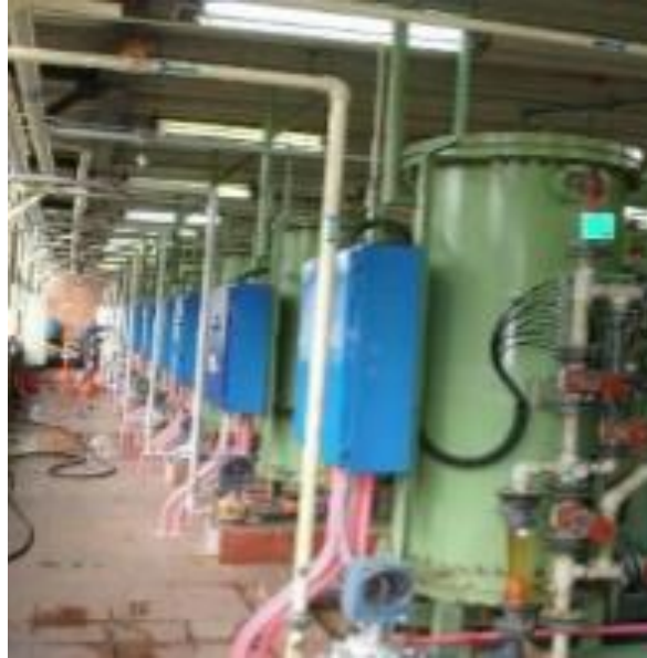
Figura 11. Trenes de desmineralización
