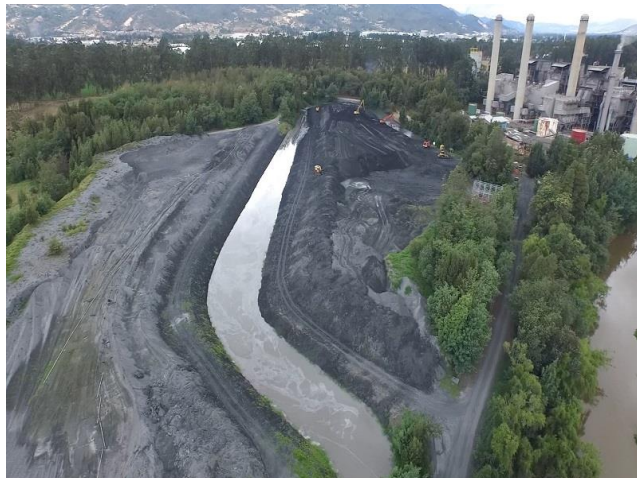
Figura 18. Vista aérea del canal de cenizas
