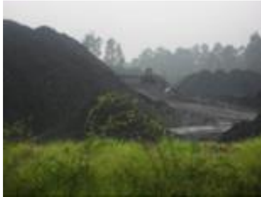
Figura 14. Patio de carbón de la central Termozipa
