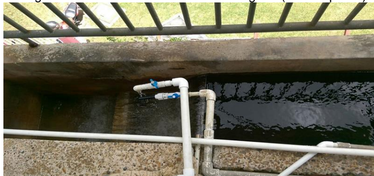
Figura 8. Vertedero de medición rectangular (vista superior)
