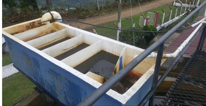
Figura 9. Vertedero de medición triangular
