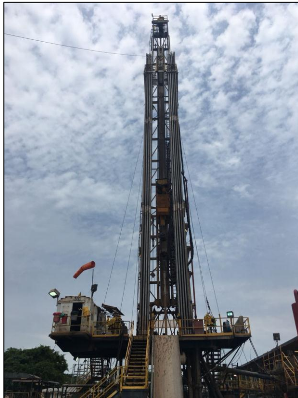
Figura 22. Equipo E1225 con paradas de 3 tubos ubicados en la mesa de perforación.
