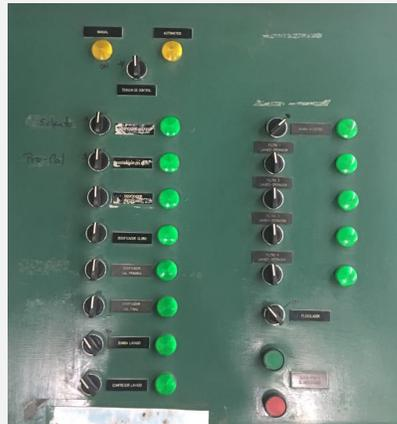
**Figura 12.** Interruptores para accionar las diferentes bombas con las que cuenta la planta piloto.
