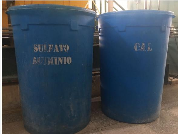
**Figura 1.** Tanques de coagulante y pre-alcalinizante, respectivamente, de la planta piloto de El Dorado.
