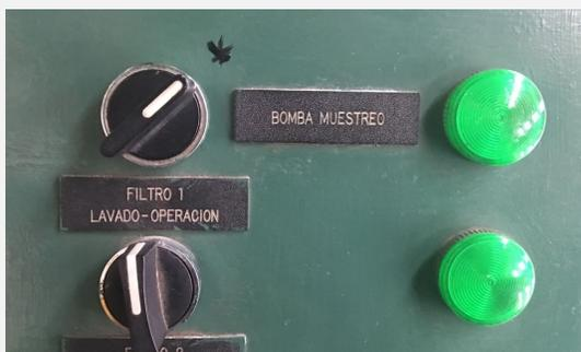
**Figura 4.** Selector de “Bomba de Muestreo” en posición de encendido.
