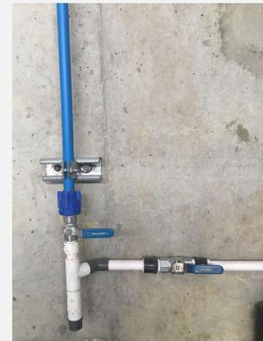
**Figura 8.** Válvulas de aire para distribución en planta piloto.
