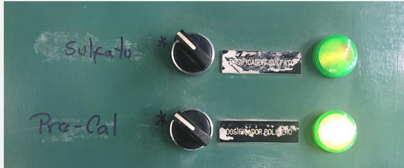
**Figura 14.** Selectores para dosificación de coagulante y alcalinizante en posición de encendido.
