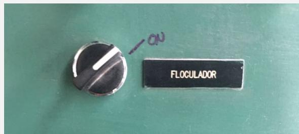
**Figura 10.** Selector de floculador en modo “ON”.
