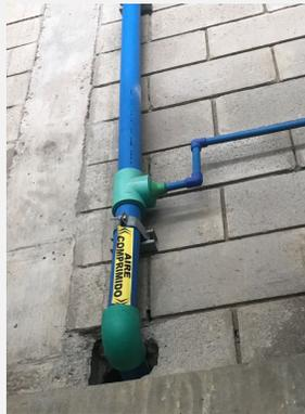
**Figura 7.** Tubería de aire comprimido.
