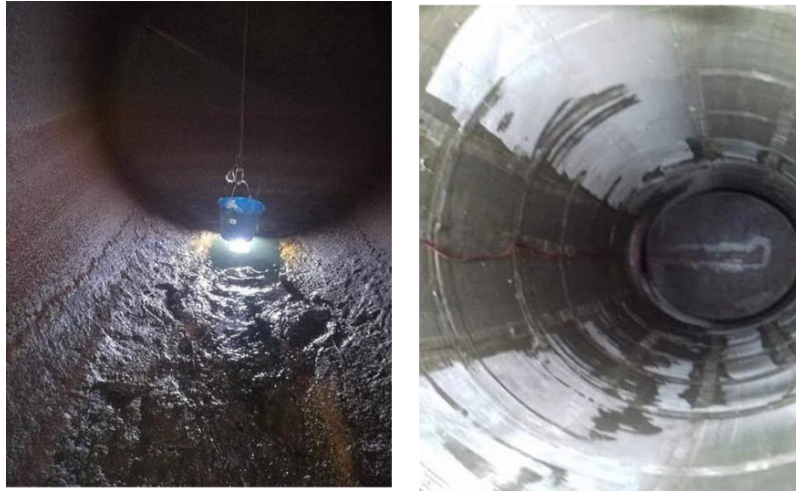
Figura 26. Tanque EDS seleccionada antes y después de ser lavado Izquierda: tanque sin lavar. Derecha: tanque lavado
