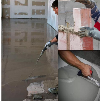
Imagen 4. Fluidez de los morteros en diferentes aplicaciones.
