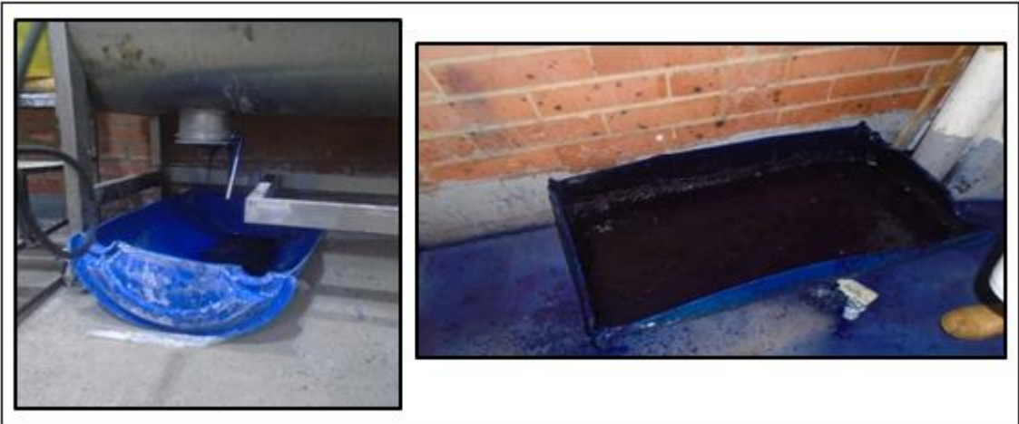
Figura 6. Residuo liquido resultante del lavado de la mezcladora.
