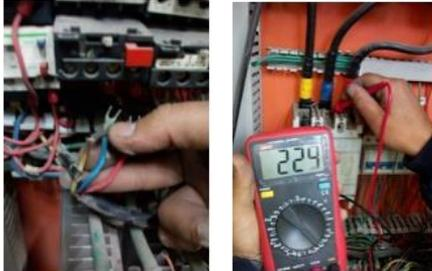
Se reaprietan todos los terminales de conexión de cada componente eléctrico, se limpian y se hacen las mediciones de los componentes más relevantes del tablero.
