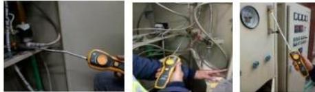
Se detectó fuga en la entrada del caudalímetro, en el acople de la manguera, se elimina ajustando la tuerca de sellado.
