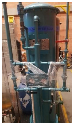
SEXTO LAZO DE CONTROL: FUNCIONAMIENTO DE SUAVIZADOR DE AGUA Y TANQUES DE ALMACENAMIENTO
