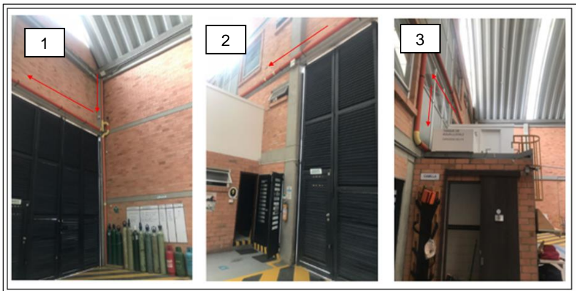
Imagen 2. Sistema de captación de aguas lluvia
