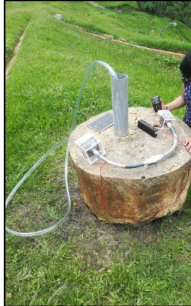
Ilustración 18. Sistema de biofiltración para remoción de H 2 S.
