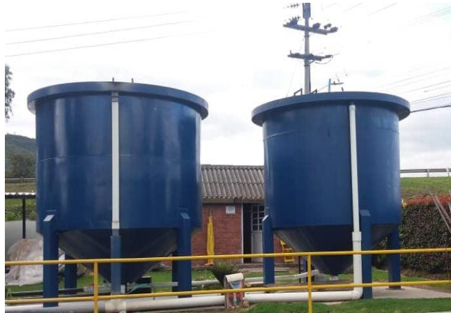
Imagen 6. Sedimentadores imhoff.
