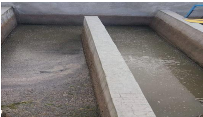
Imagen 3. Trampa de grasas con estructura tubo en forma de T.
