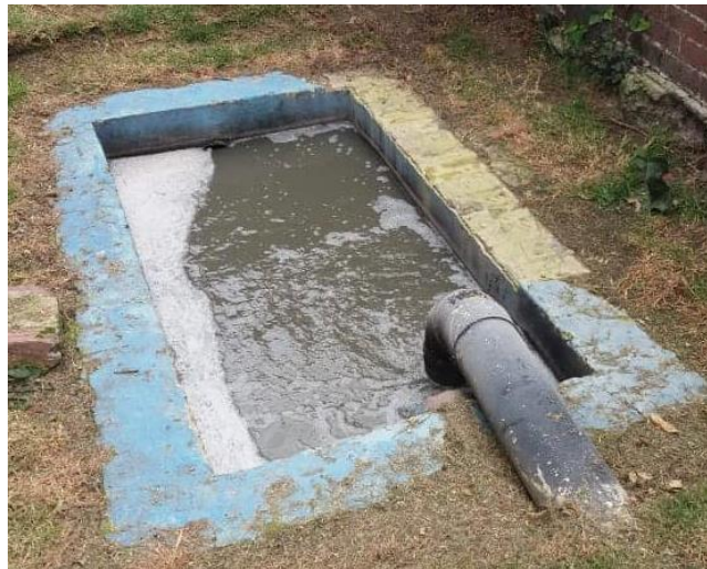
Imagen 7. Tanque de desinfección.
