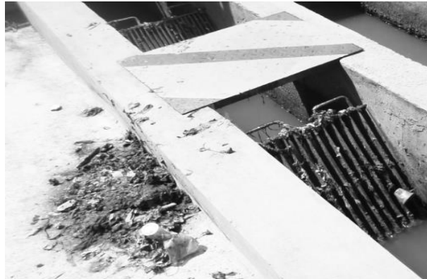
Imagen 2. Sistema de cribado grueso y fino.
